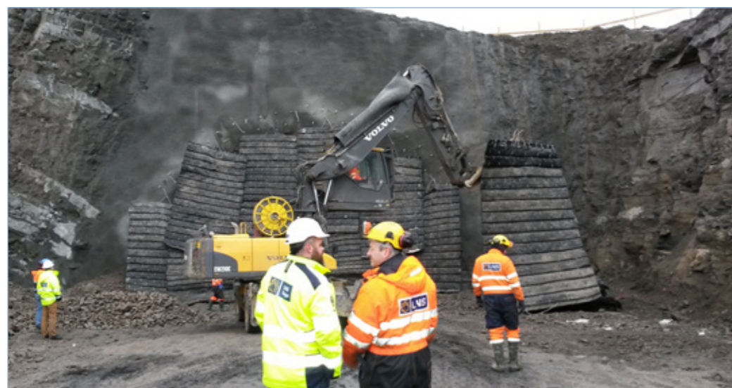
Jarðgöng undir Húsavíkurhöfða, fyrsta sprenging undirbúin 10. mars 2016.
