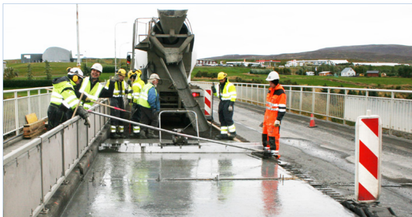
Hringvegur (1), endurnýjun slitlags á brú yfir Blöndu á Blönduósi 14. september 2016.
