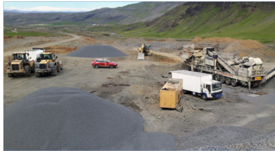
Kjósarskarðsvegur (48), Fremri Háls - Þingvallavegur, efnisvinnsla, 28. júlí 2016.
