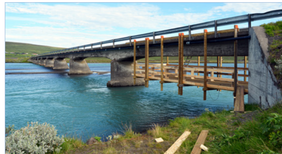
Norðausturvegur (85) um Skjálfafljót, 23. júní 2016. Unnið hefur verið að hönnun og undirbúningi nýrrar brúar um árabíl. Myndin sýnir verkpalla þegar núverandi brú var styrkt með koltrefjaplötum vegna flutninga á steypuefni fyrir framkvæmdir á Bakka við Húsavík.
