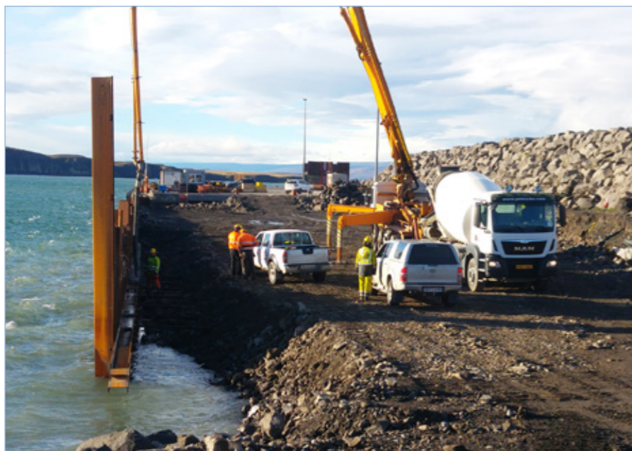
Húsavík í Norðurþingi, lenging á stálþiltsbakka Bökugarðs 22. september 2016.
