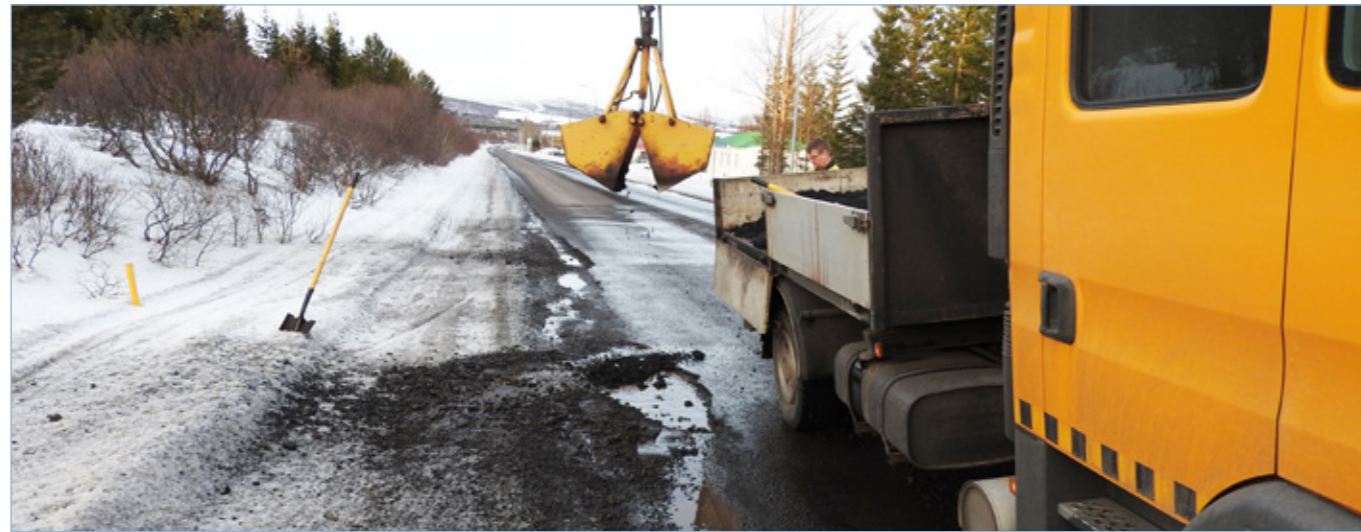
Laugarvatnsvegur (37) á Laugarvatni. Skemmdir á slitlagi lagfærðar 1. mars 2016.
