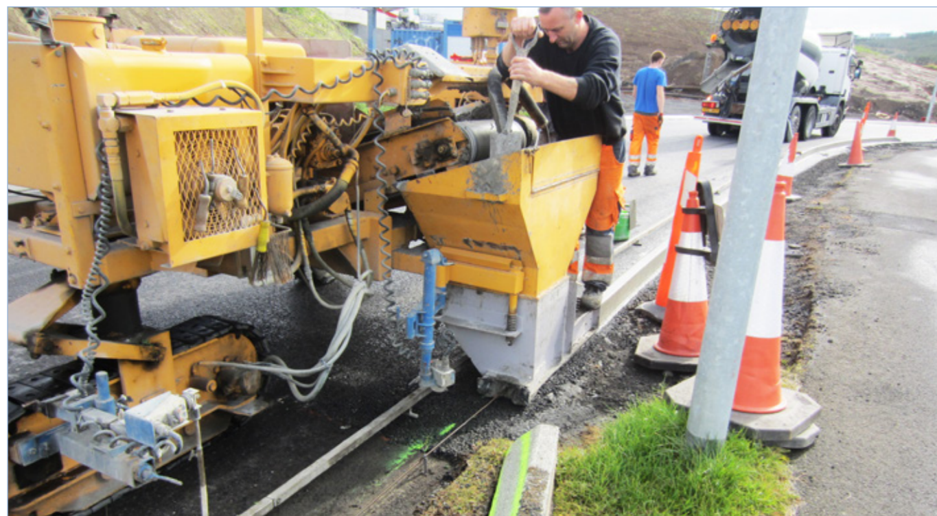
Arnamesvegur (411), kantsteinn steypur 26. ágúst 2016.
