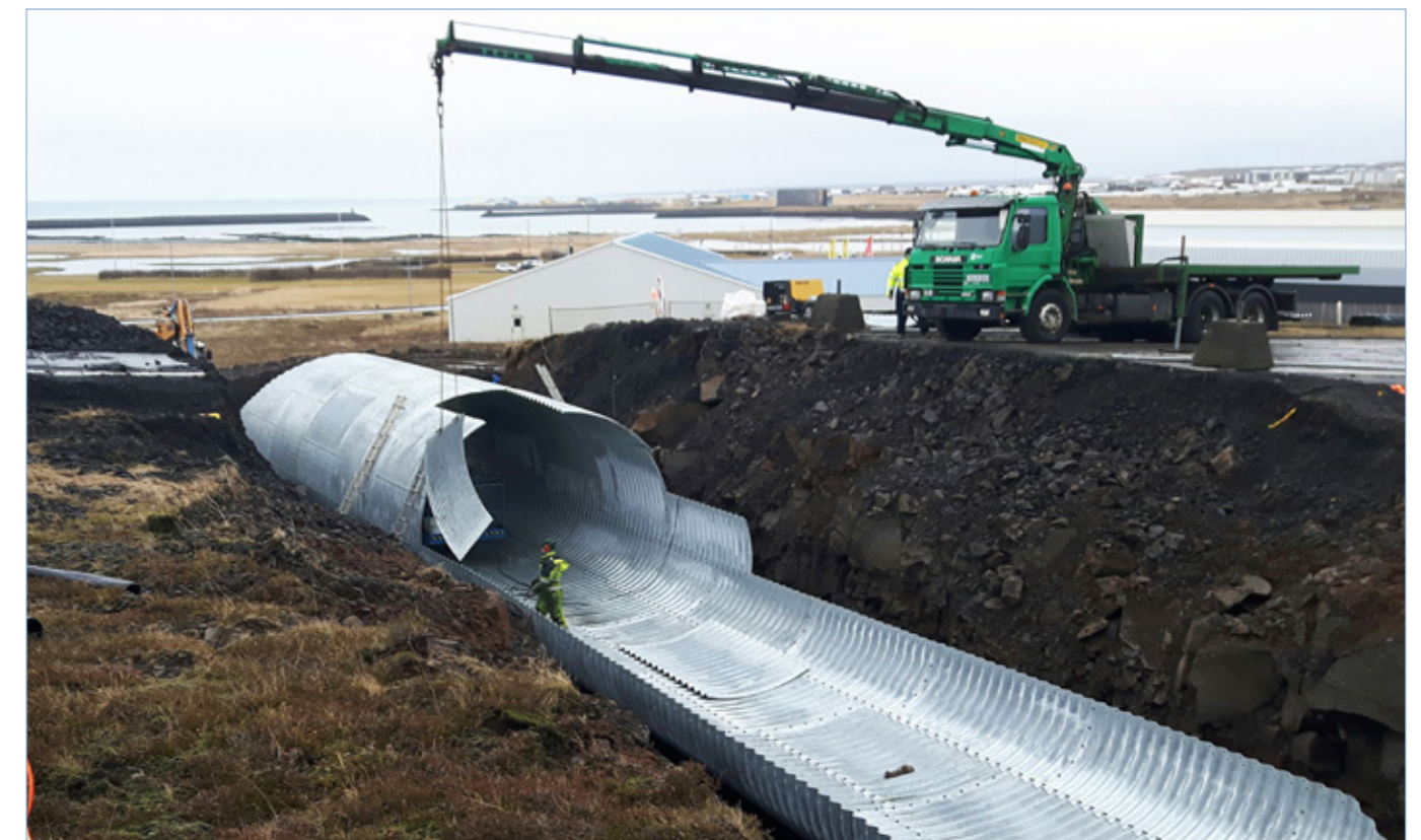
Reykjanesbraut (41), undirgöng við Hafnaveg, 14. nóvember 2016.
