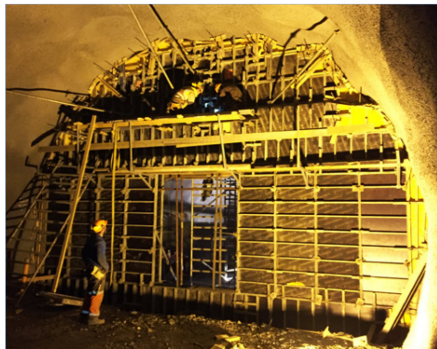
Norðfjarðargöng, vinna við tækni- og öryggisrymi 28. nóvember 2016.
