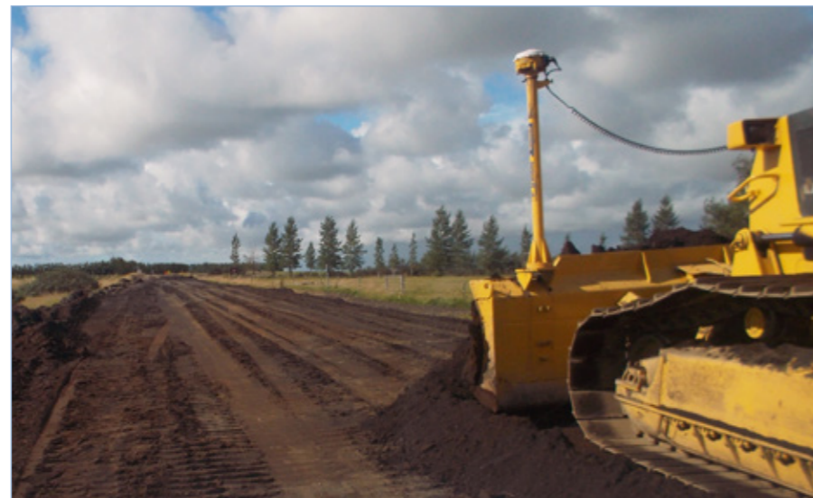
Árbæjarvegur (271), vegagerð, 18. ágúst 2016.
