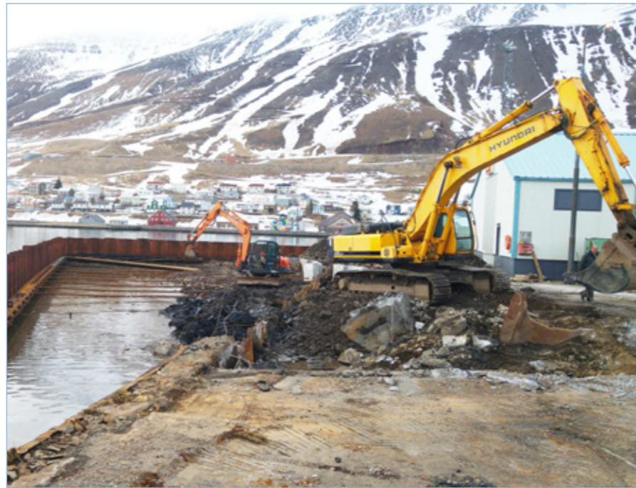
Siglufjörður í Fjallabyggð, endurbygging Bæjarbryggju 18. maí 2016.
