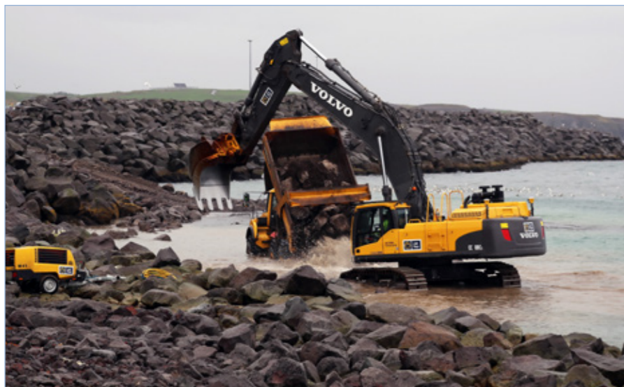
Húsavík, unnið við brimvarnargarð 11. ágúst 2016.
