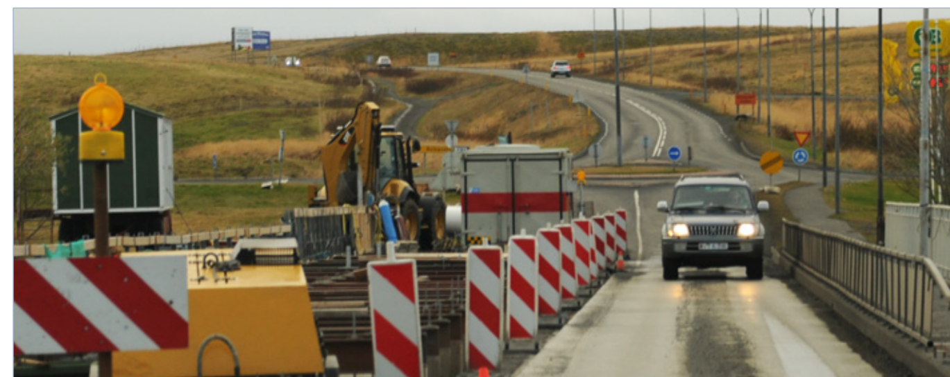
Blöndubrú á Blönduósi, viðgerð 30. október 2016.
