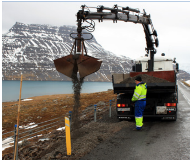
Djúpvegur (61) í Seyðisfirði, Fjallið Hestur í baksýn. Efni sett í vegaxlir 15. mars 2016.
