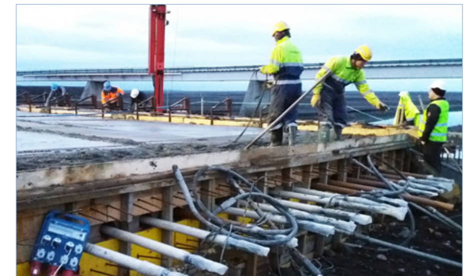
Morsá, steypuvinna 16. október 2016. Skeiðarárbrú í baksýn.
